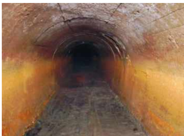
図 2-3-5-30 <<老朽化した下水道管渠の更新>>
