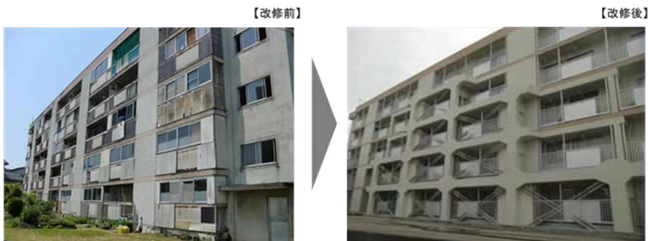
図 2-3-4-16 <<市営住宅の耐震改修例（昭和団地）>> (出典:長岡市)
