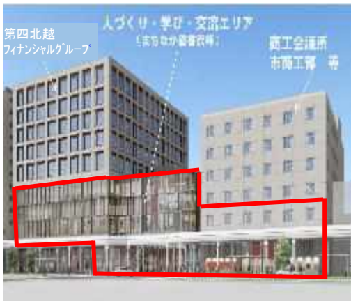
○大手通坂之上町地区の市街地再開発事業 ○市は、人づくり・学び・交流エリアを整備 (令和7年度完成予定)
