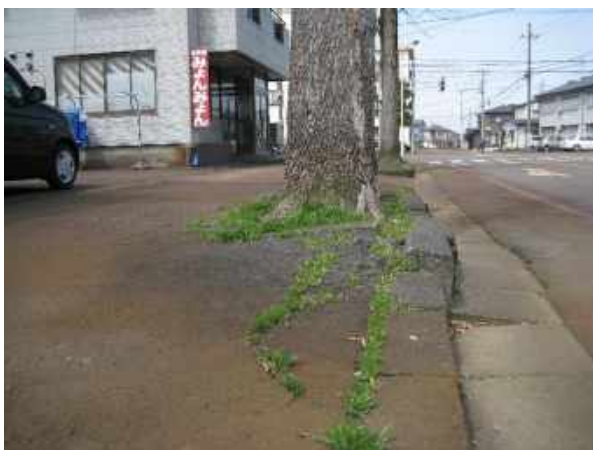
図 2-3-3-5 《巨木化による道路の破損》
