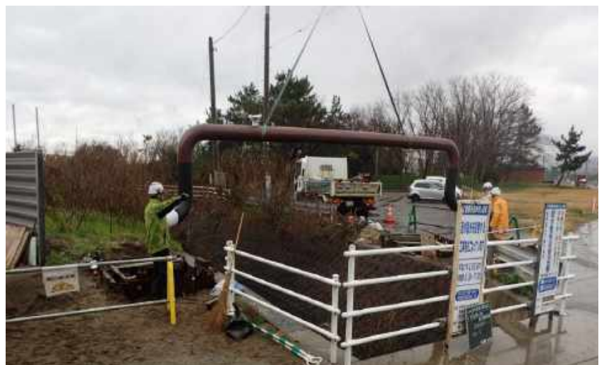
図 2-3-5-20 《管路の耐震化の例》 (耐震管路布設工事(寺泊地内))
