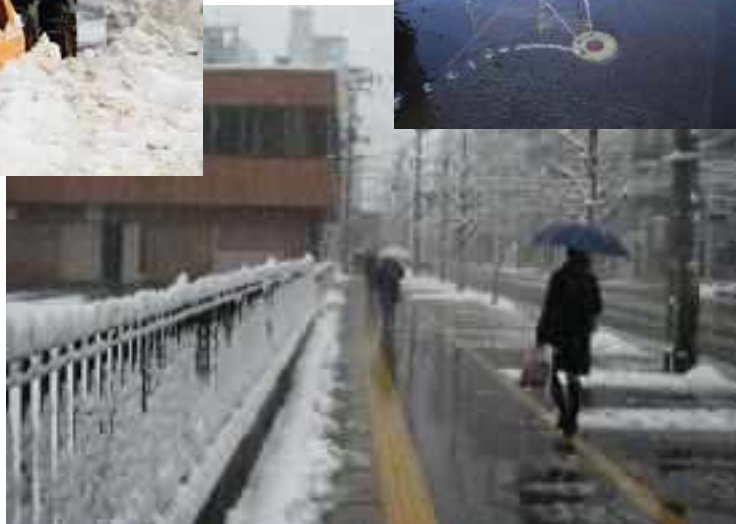
図 2-3-2-19 ≪機械除雪、消雪パイプによる除雪≫
