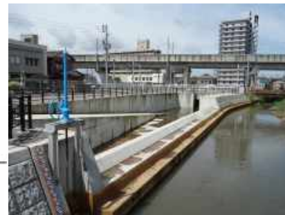
放水路の整備（柿川）
