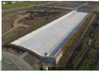
雨水調整池（北スマート流通産業団地）
