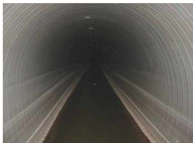
図 2-3-5-30 <<老朽化した下水道管渠の更新>>
