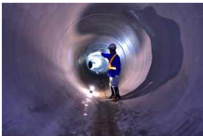
図 2-3-5-11 ≪表町貯留施設≫
