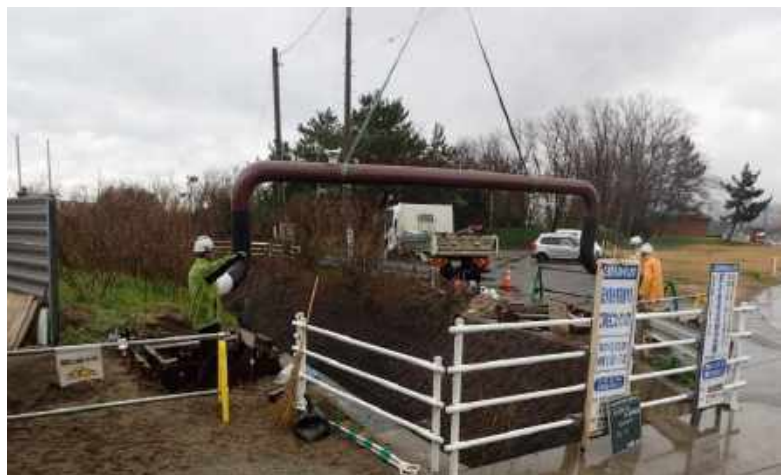
図 2-3-5-19 《管路の耐震化の例》
