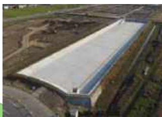
雨水調整池(長岡北スマート流通産業団地)
