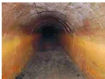
図 2-3-5-29 《老朽化した下水道管渠の更新》
