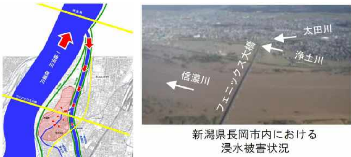
図2-3-5-4 <<令和元年台風第19号被害状況(バックウォーターによる浸水被害の様子)>>
