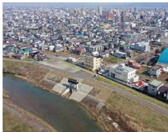
図 2-2-7 ≪柿川放水路 (2019 年竣工)≫ (出典:長岡市)
