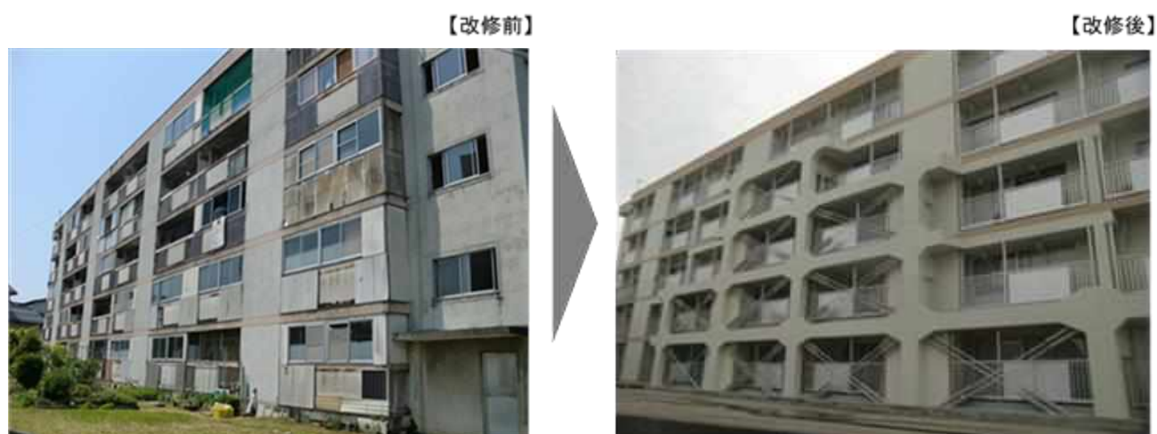
図 2-3-4-16 ≪市営住宅の耐震改修例（昭和団地）≫
