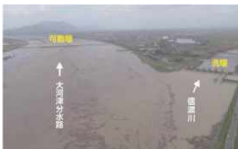
信濃川中流域出水状況
