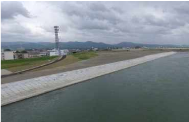
図 2-3-5-9 《信濃川流域の治水安全度を高める 信濃地区築堤護岸の改修》
