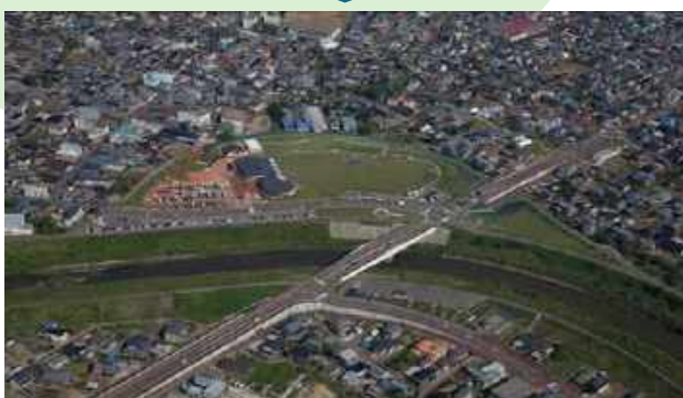
河道の改修が完了した刈谷田川(中之島地域)
