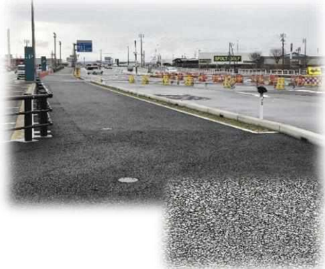
図 2-4-1-18 《道路の透水性舗装》
