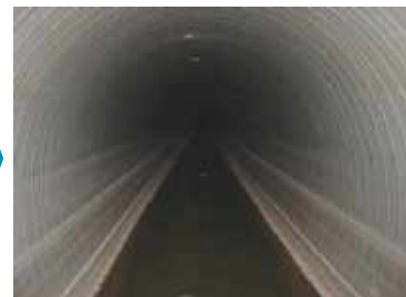
図 2-3-5-29 《老朽化した下水道管渠の更新》
