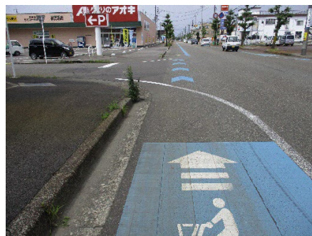
写真 ブルーラインの設置例
