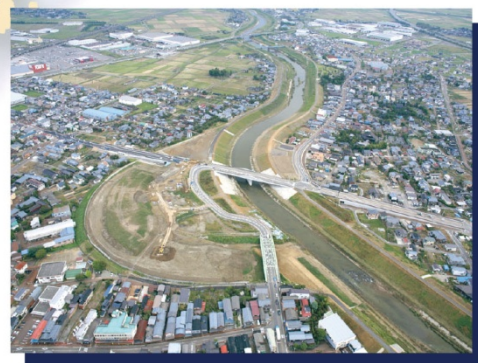
水害の防止に向けて、屈曲部のショートカット工事を行った「刈谷田川」
