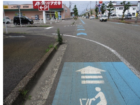
写真 ブルーラインの設置例
