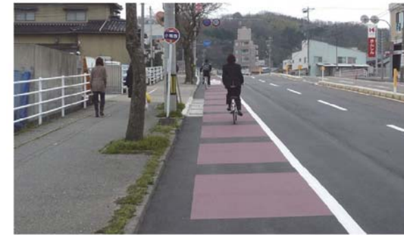
図-10 破線状の自転車レーンの着色（灰桜色系）と車道との境界部に白線の設置
