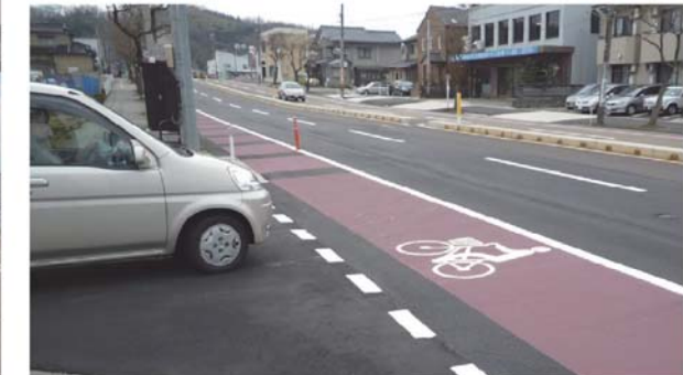
図-13 路地との交差部において注意喚起の路面標示
