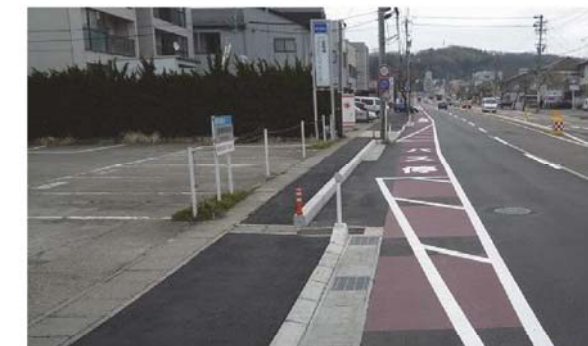
図-14 バス停部での路面標示
