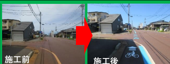
R6年度施工箇所（南中学校前）
