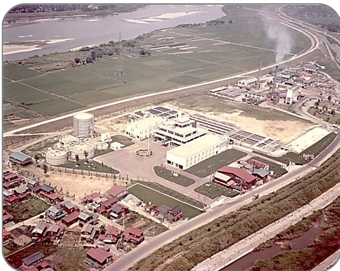
運転開始当初（昭和 52 年頃）の長岡中央浄化センターと信濃川
