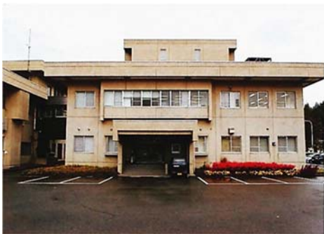
栃尾下水処理センター
