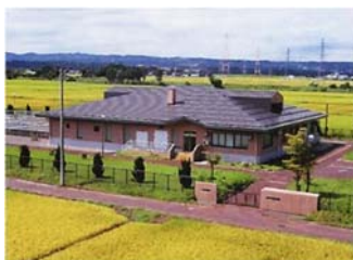
岡南南部浄化センター
