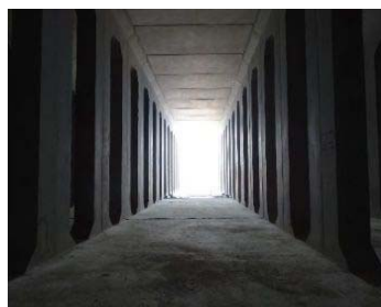
琴平公園貯留施設
