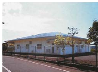
桐原地区集落排水処理場
