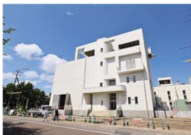
寿町排水ポンプ場
