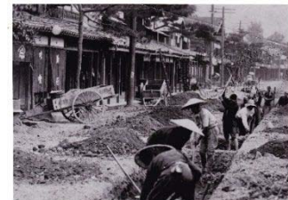
第一期下水道事業（本町 3 丁目）
