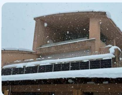
雪が多い地域の建物の壁面に軽量型の太陽光パネルを設置しています。発電量やパネルの耐性を確認しています。
