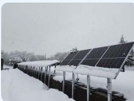
降雪や強風に適応して角度を変えるパネルを設置しています。雪国長岡の特性に合った角度を検証しています。
