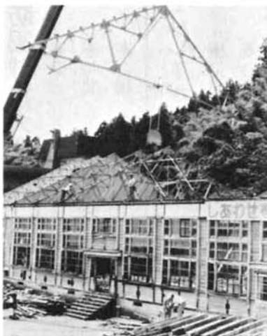
▲クレーンで解体作業中
