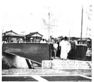
▲完成した歩道橋「ひまわり橋」
