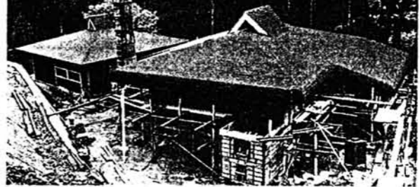
着々とすすんでいる工事現場
