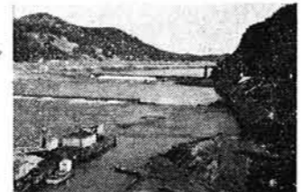
(野積橋より寺泊町取水塔を望む)
