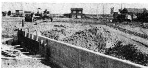
整地作業中のブル
