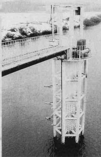
昭和46年に完成し、当時から使われている取水塔
