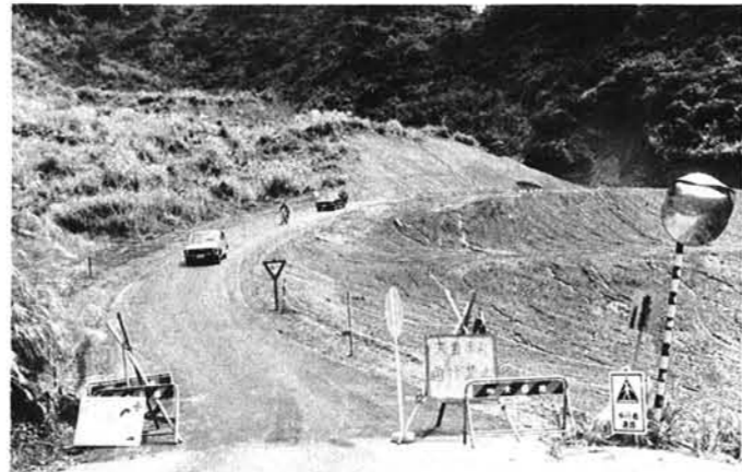
開通した仮設道路
