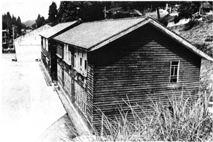
新築が予定されている虫亀小学校
