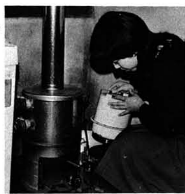
油はよくふきとる。また、風呂がまの水量に注意して空焚きは絶対にしないように。
