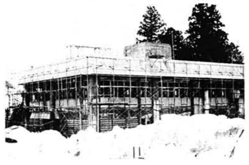
建設中の錦鯉総合センター
