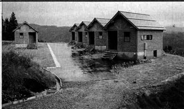
▲シャワールームをそなえたログハウス5棟が完成
