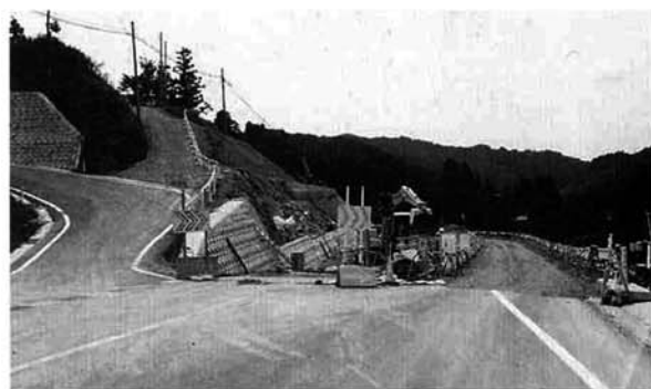
▶R291号道路改良事業(竹沢地内)
