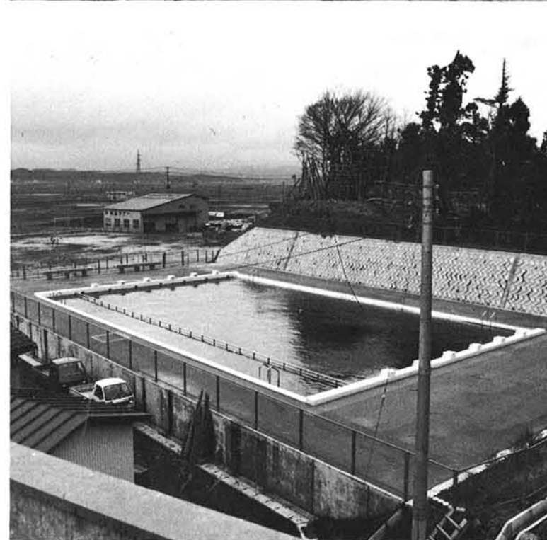
同型式の桐島小学校プール(昨年完成)
