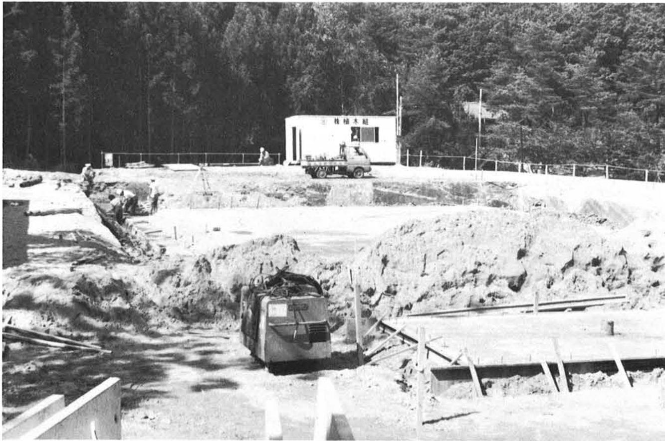
工事中のプール
