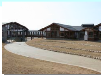
▲廊下から見る中庭と教室
