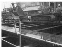
工事の進む島崎大橋
