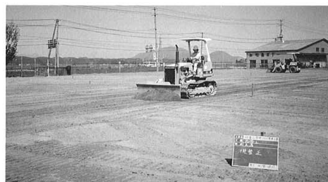
▲桐島小グランド整備工事
