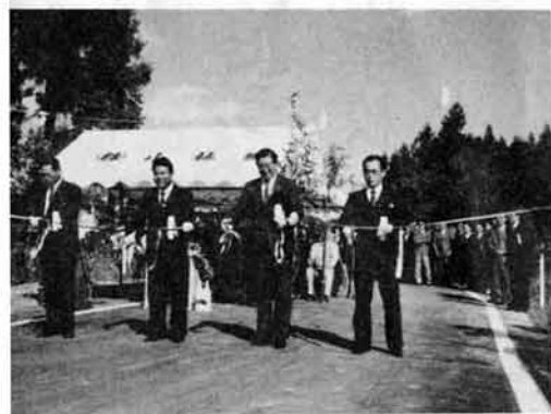
市道下塩・下榎出・山屋線の河原田橋拡幅工事の竣工式
