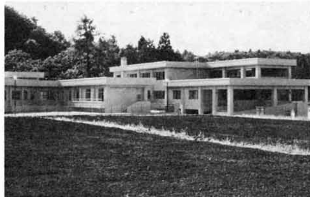
体育館建設ですべて完成する守門の里
