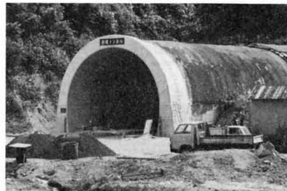
早い時期の開通が待たれる新榎トンネル
