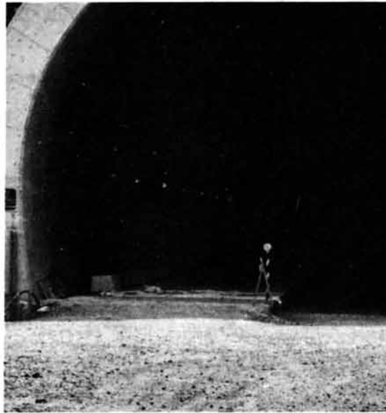
着々と進むトンネル内舗装工事
