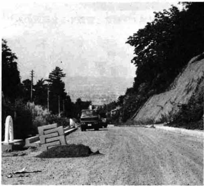
長岡側道路工事は最後の舗装工事
