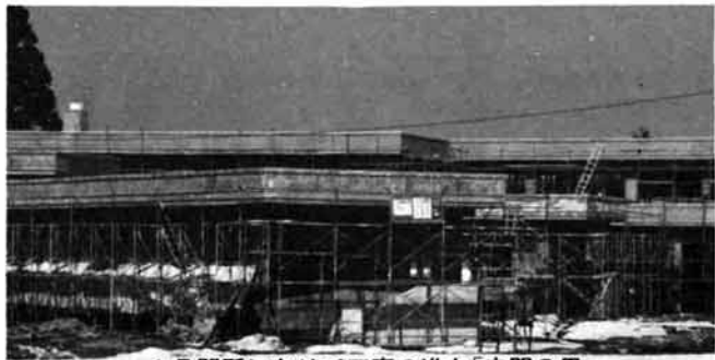
9月開所に向けて工事の進む「守門の里」
