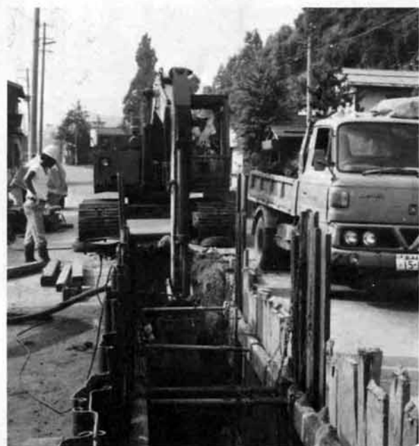
市内各地で進む下水道工事
