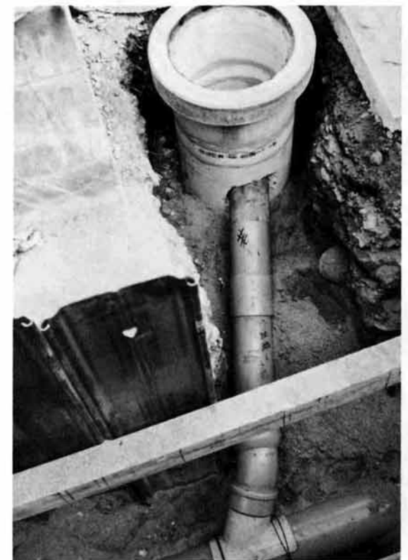
設置工事中の汚水ます
