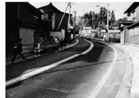
新町(栃尾印刷前信号)～小貫(重助茶屋前)
