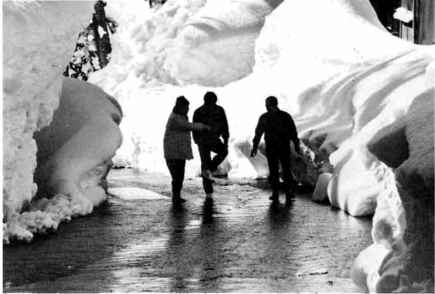
急な坂道も、水を流すことにより、無雪化できる(栗山沢地内の路面流水道路)
