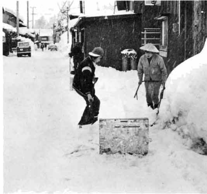
流雪溝が整備された地区では、降ろした屋根雪を効率よく片づけることができる(大野町地内)
