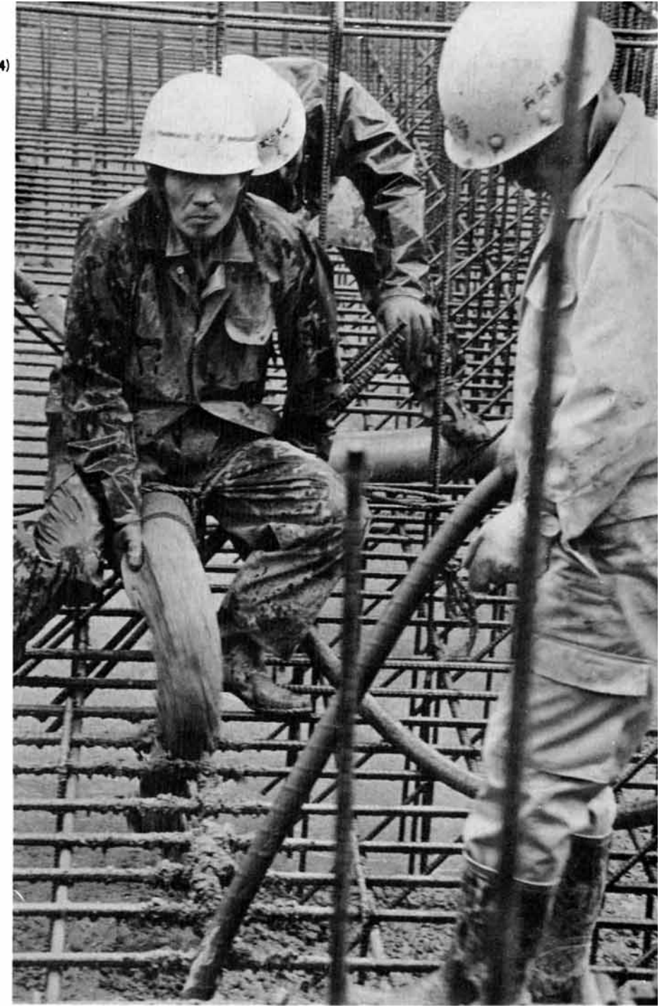
息ピッタリに進められる機械棟のコンクリート打設
