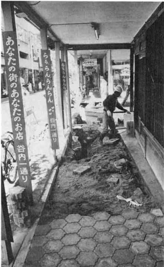
ガス管を移動して行われたブロック敷工事
