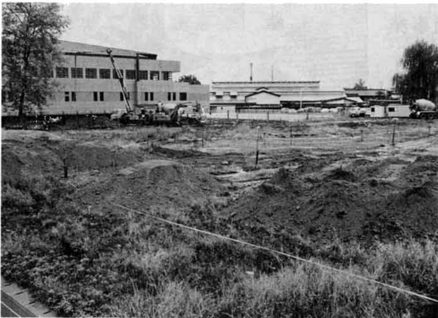
今年度は後方に池の基礎と周囲の園路基礎工事を行います
