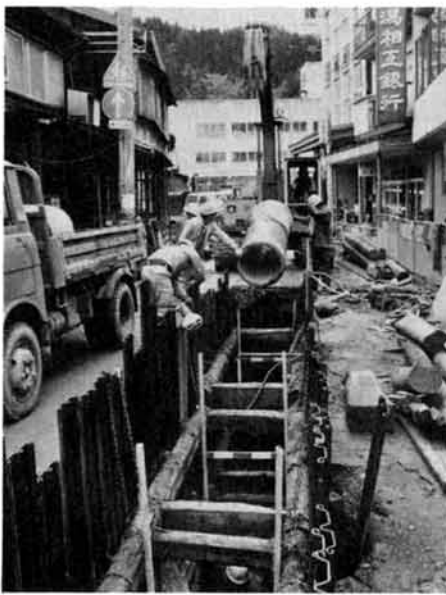
3.2メートルに埋設する幹線管 (11月1日日本町)
