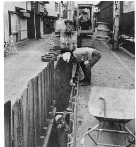
枝線管の埋設（金町1丁目）
