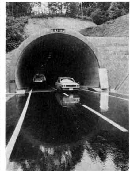
大型車も悠々交互通行できるようになった梨ノ木トンネル
