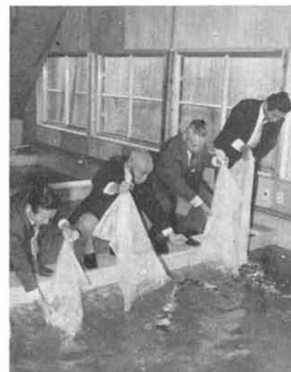
1階に造られた5基の水槽に錦鯉が放された
