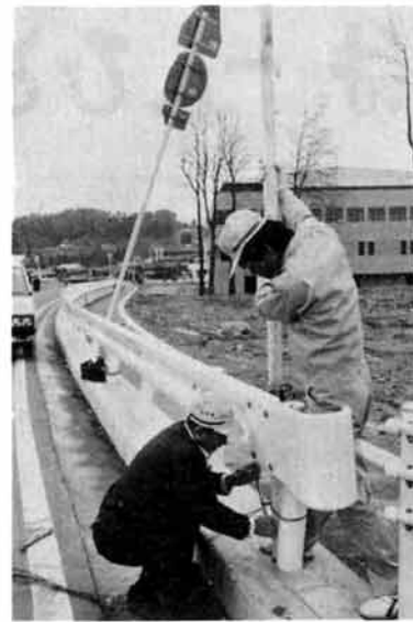
折れた標識を立て直す応急措置
