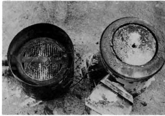
火災原因のふろ釜、熱交換器に大量のススが付着している
