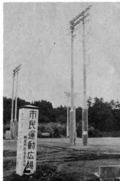
夜間照明設備
