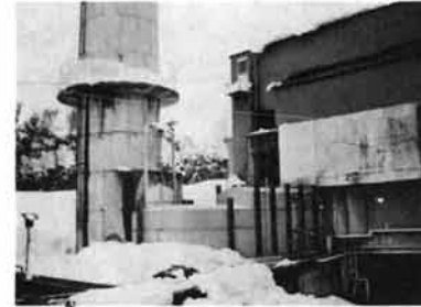
清掃センター煙道
