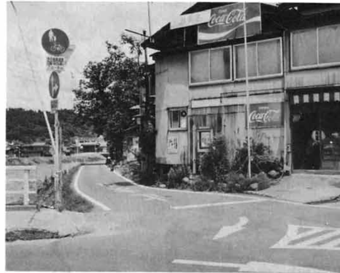
市道金沢・平堤防線改良(右手の住家を移転した)
