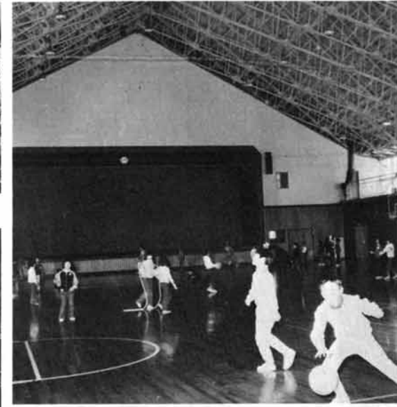
栃尾南小学校屋内運動場
