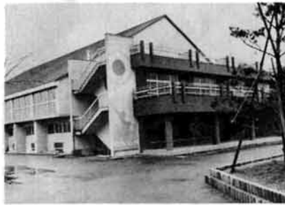
簡易保険還元融資の資金で建築した東小体育館
