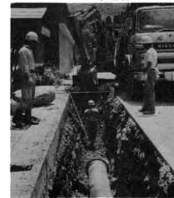
水道管理設工事
