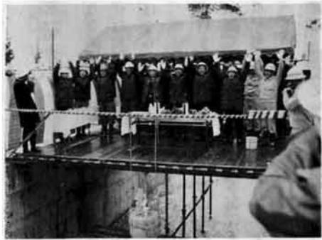
ダム転流工事通水式(49・12・9)
