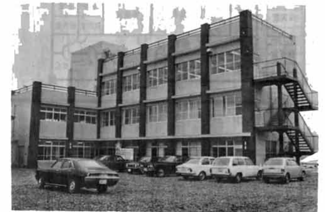
▲塩谷地区開発センター 5月に開館した塩谷地区開発センターは、鉄筋コンクリート3階建延748㎡、各種集会等広く利用できます。総事業費4,709万円のうち郵政省から1,750万円の簡易生命保険の還元融資を受けました。
