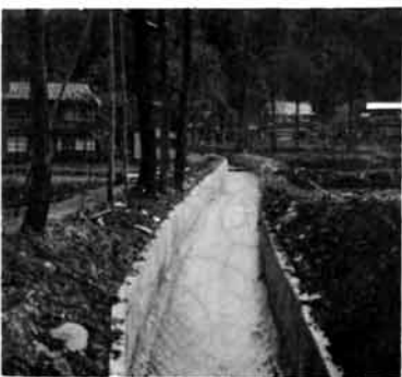
▲普通河川改修事業 栃堀地内栃堀沢川
