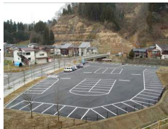
完成した秋葉公園駐車場
