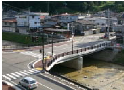
今年3月25日に開通した新金橋。約3年の歳月をかけ完成しました
