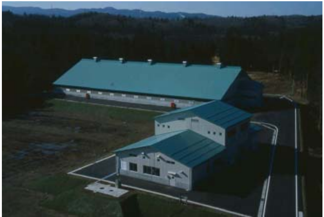
4月1日から供用を開始した栃尾市最終処分場。汚水を出さない環境にやさしいシステムと塩と水の再利用システムで、安全な暮らしの確保を目指します
