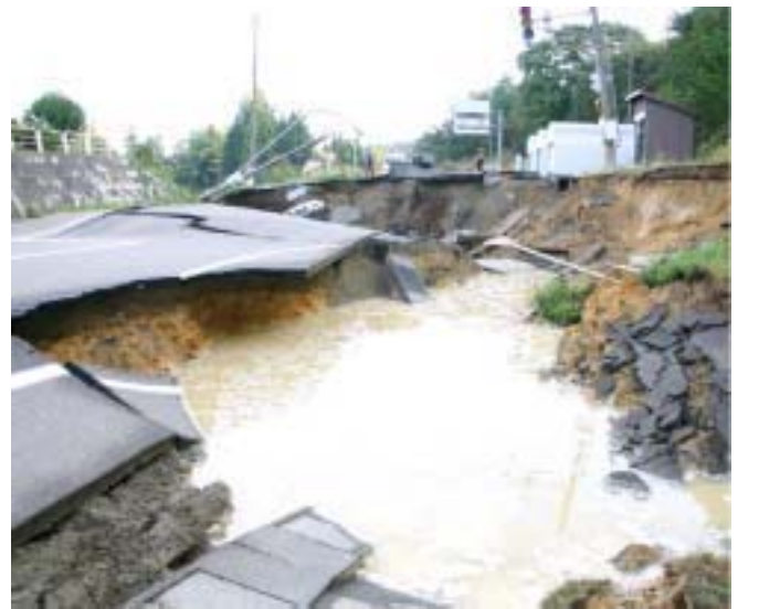
中越大地震で寸断された国道351号。直ちに復旧作業を行い11月19日に開通、栃尾市の生命線が確保されました(本津川地内)
