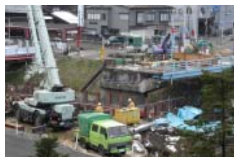
急ピッチで工事が進む新金橋
