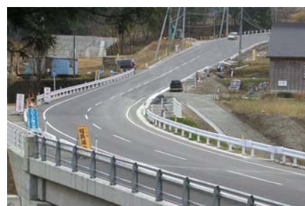
交通の難所を解消した栃尾守門線。左手奥は繁窪橋(仮称)の橋台
