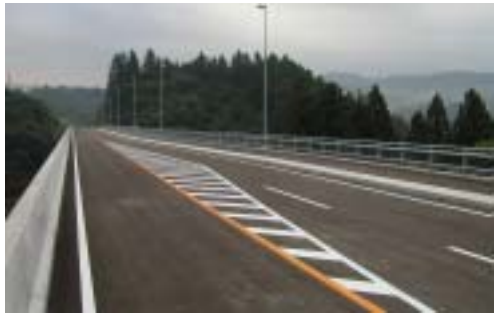
開通を待つ「とちお大橋」
