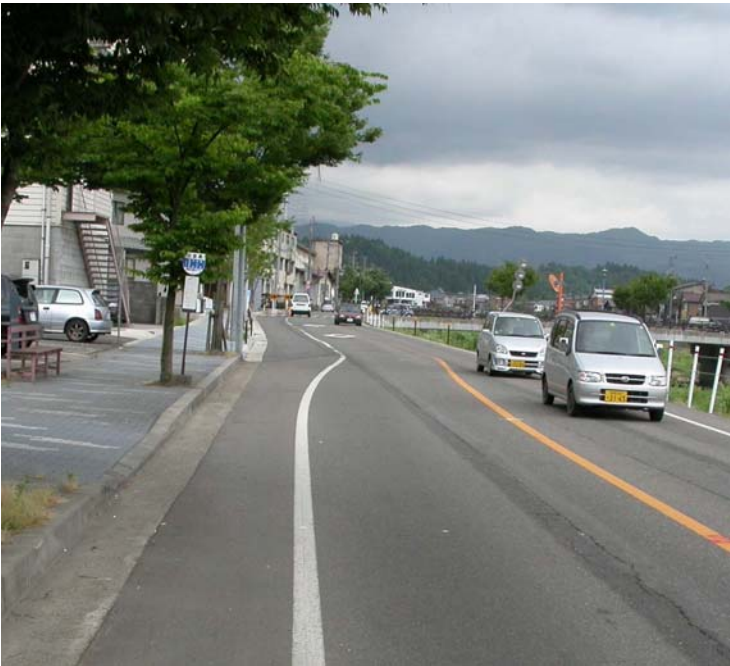
過疎債を活用し整備を進める金沢平堤防線。補てん率の高い有利な起債を選択し、事業を行っています
