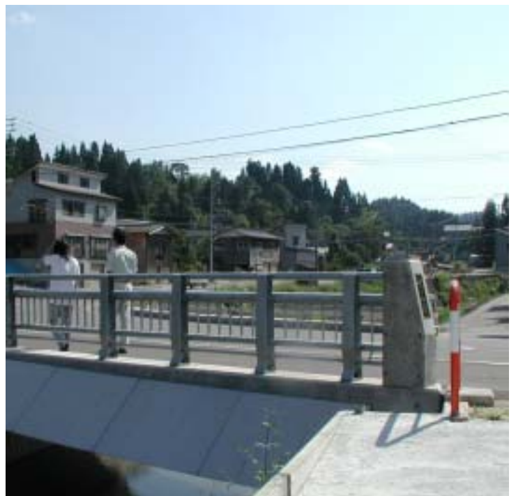
昨年12月22日に竣工式を行った赤谷橋。今年度は、赤谷地内の道路の拡幅工事を進めています
